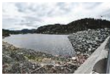
LÅGE MAGASIN: Tunhovddammen, ein del av kraftverket Nore I, i juli. Foto: NTB Scanpix
